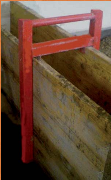
aide coffrage en service
