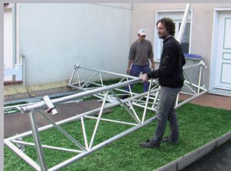
Assemblage des sections de passerelle par double mamelons + goupilles
