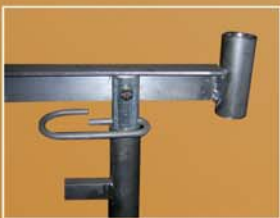
Détail du clavetage de la hausse
